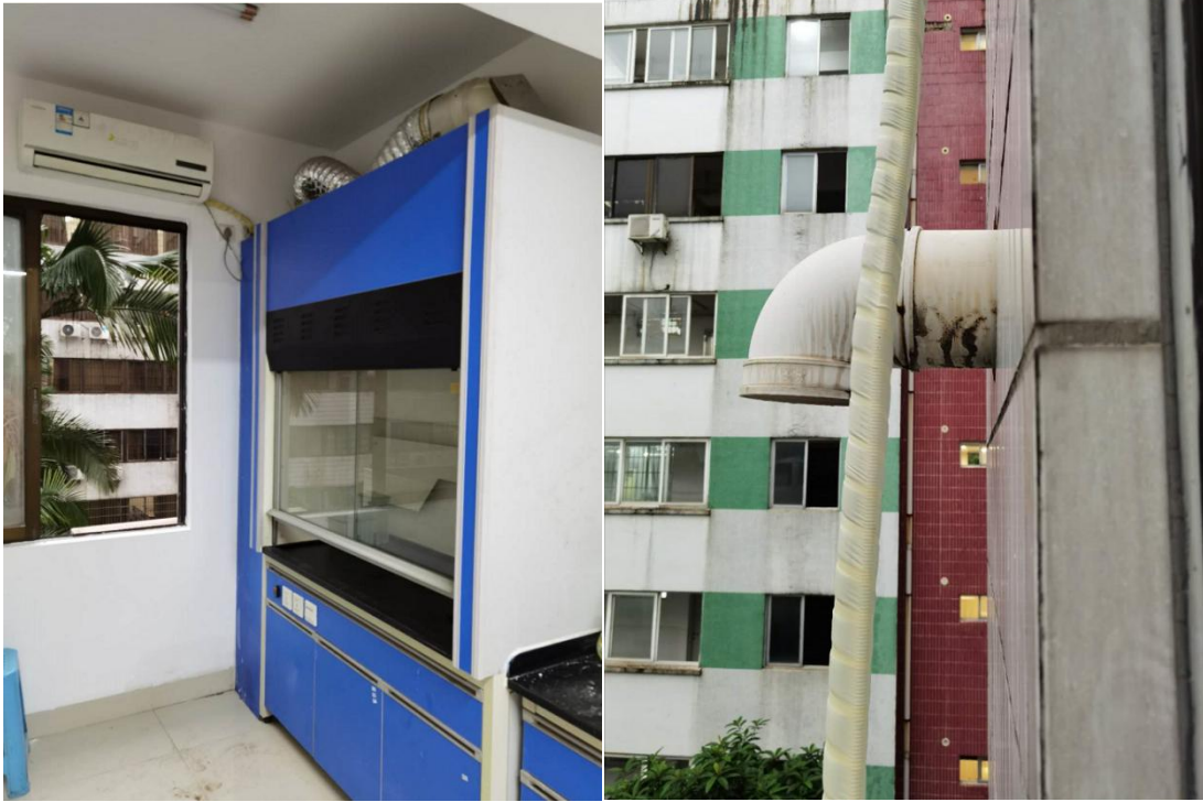
附件 2： 尚未整改仍存在排废气问题的通风橱及管道
